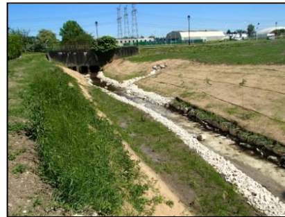
En phase travaux
