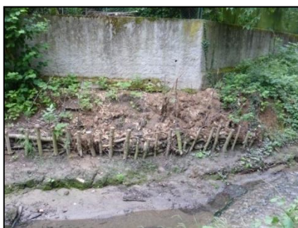
Dépôt de déchets verts pour maintenir la berge
