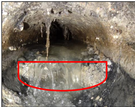
Billes de graisse (entouré en rouge) obstruant la moitié de la conduite
