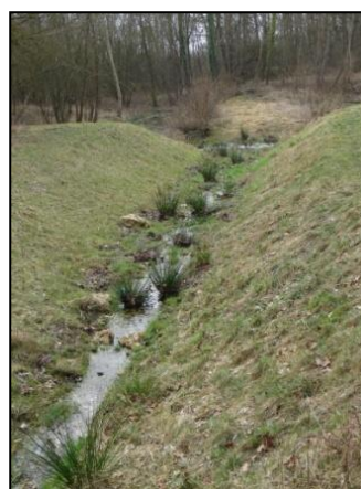
Vue de face après travaux
