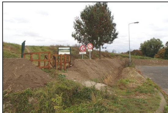
Chicane anti-intrusion, fossés et merlons à l'entrée de l'Etang du Coq
