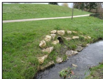
Exutoire N°2 : Après travaux
