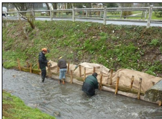
Travaux de renforcement des berges en 2013 puis entretien et sélection des tiges de repousse
