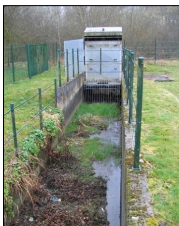
Vue de face avant travaux
