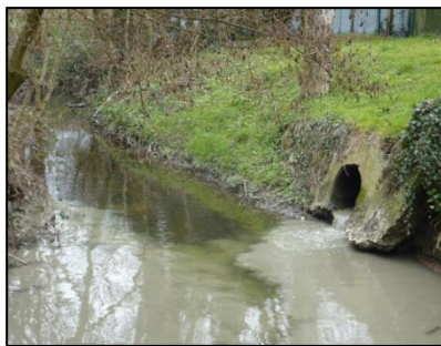
Pollution aux eaux usées issue d'un défaut d'entretien
