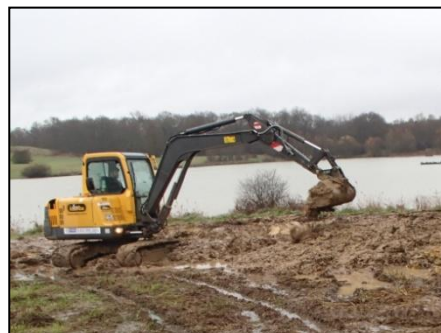
Excavation à la pelleteuse
