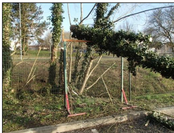
Armature permettant de protéger la clôture lors de la découpe
