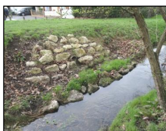
Exutoire N°1 : Après travaux
