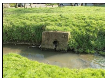
Exutoire N°2 : avant travaux
