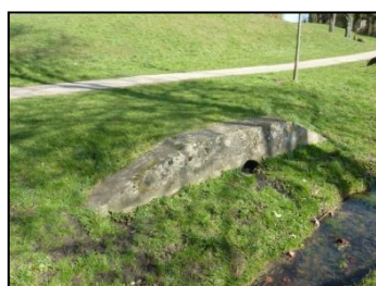
Exutoire N°2 : avant travaux
