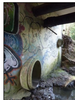
Rejet permanent à Pontault-Combault Rue de la chaussée
