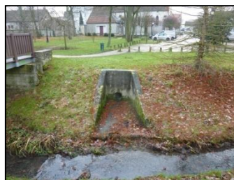
Exutoire N°1 : avant travaux
