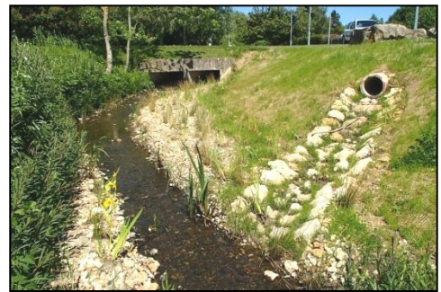
Projet pilote : Recul d'un exutoire d'eau pluvial à Roissy-en-Brie
