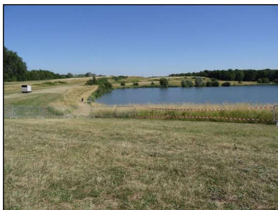
Préparation de la zone d'accueil
