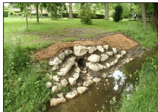
Aménagement d'un exutoire d'eau pluvial
