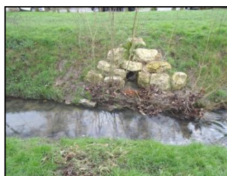
Exutoire N°2 : Après travaux
