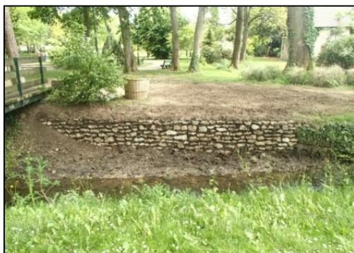
Prolongement d'un mur en pierres sèches
