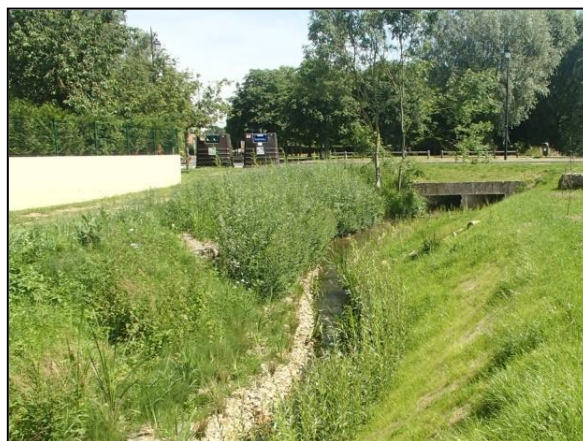
Etat après travaux
