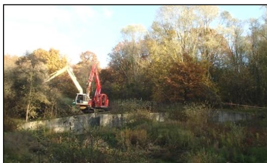
Vue de derrière en phase travaux
