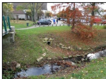
Exutoire N°1 : Après travaux
