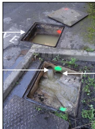
Communication entre le réseau d'eaux usées et d'eaux pluviales permettant la pollution du Morbras
